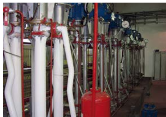
АГРЕГАТ В ЭКСПЛУАТАЦИИ , ПЕРЕКАЧИВАЕМЫЙ ПРОДУКТ – МЕТАНОЛ (-50°С)
